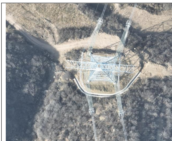
N1315 浆砌石排水沟
