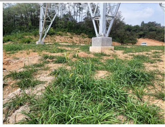
施工单位已整改，进行土地整治，同时撒播草籽
